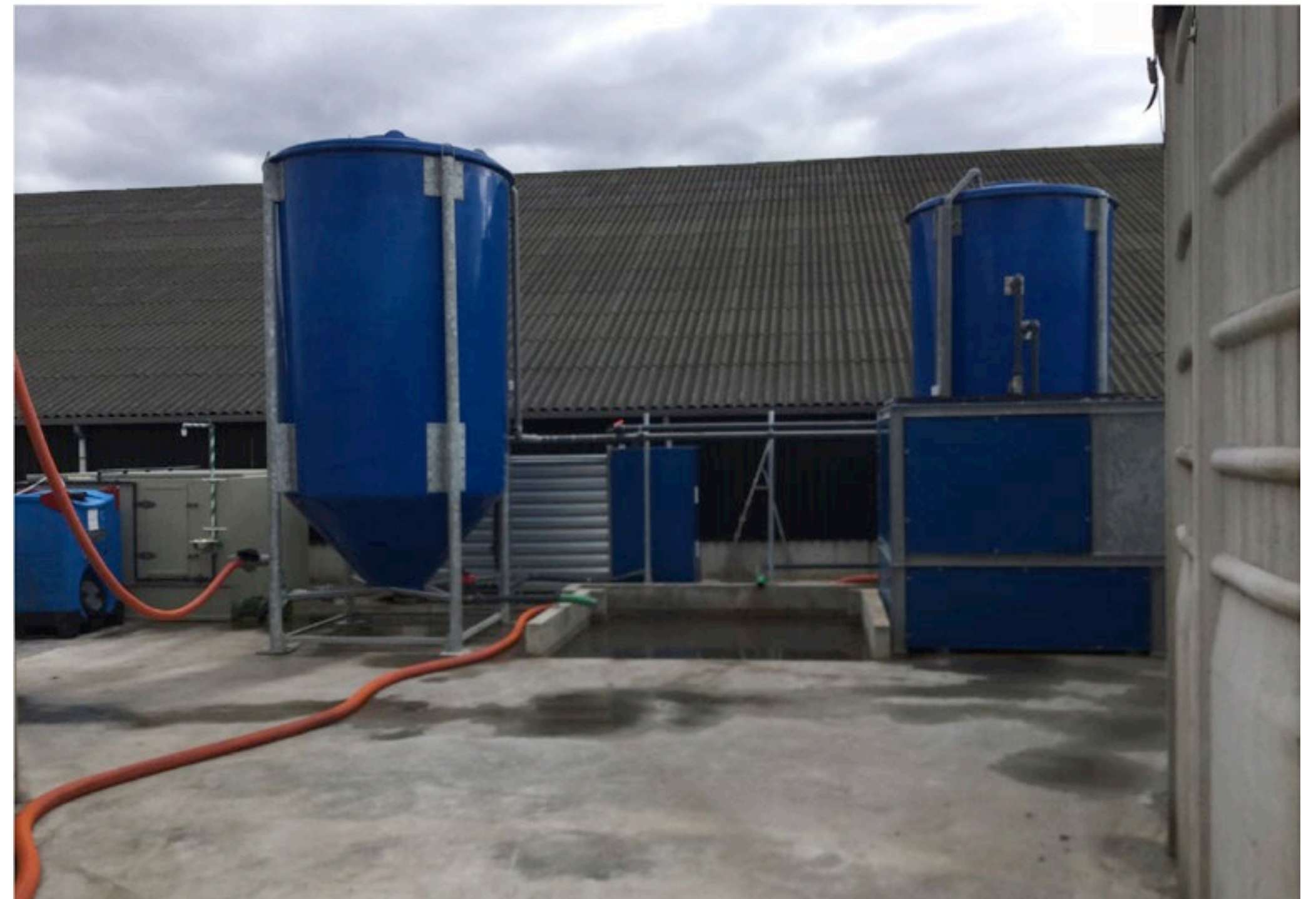
Huidige opstelling op praktijkbedrijf
